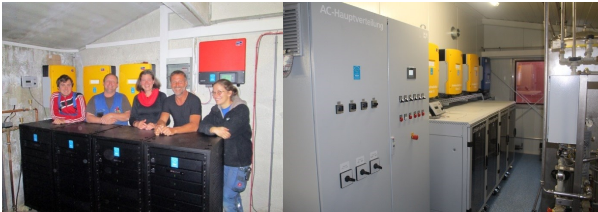
Abbildung 2: Vergleichbare Beispielanlage Lithium-Ionen-Akku des Typs „Fortelion“ von Sony mit Lithium-Eisenphosphat-Technologie und 3 phasigem Sunny Island System auf der Ostpreußenhütte und in der Forschungsstation Gondwana in der Antarktis
