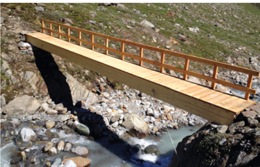
Unten: Zum Schutz vor Lawinen und Schmelzwasser müssen viele Brücken jedes Jahr ab- und wieder aufgebaut werden
