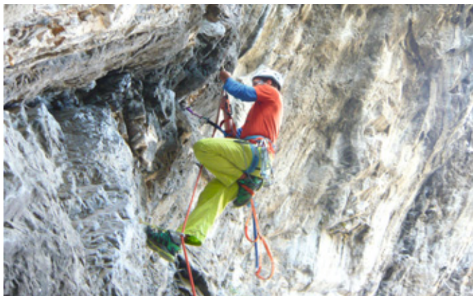
Überwinden einer überhängenden Passage mithilfe von mobilen Sicherungsmitteln und Steigleitern
