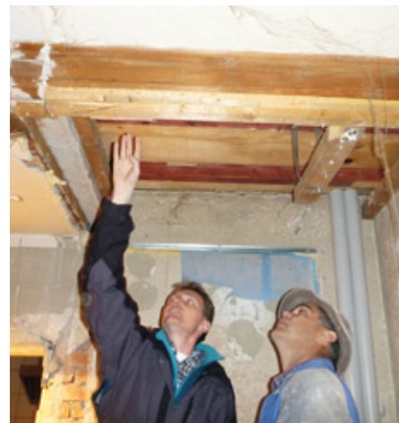
Hielt die Sektion 2013 in Atem: die Generalsanierung der Albert-Link-Hütte
